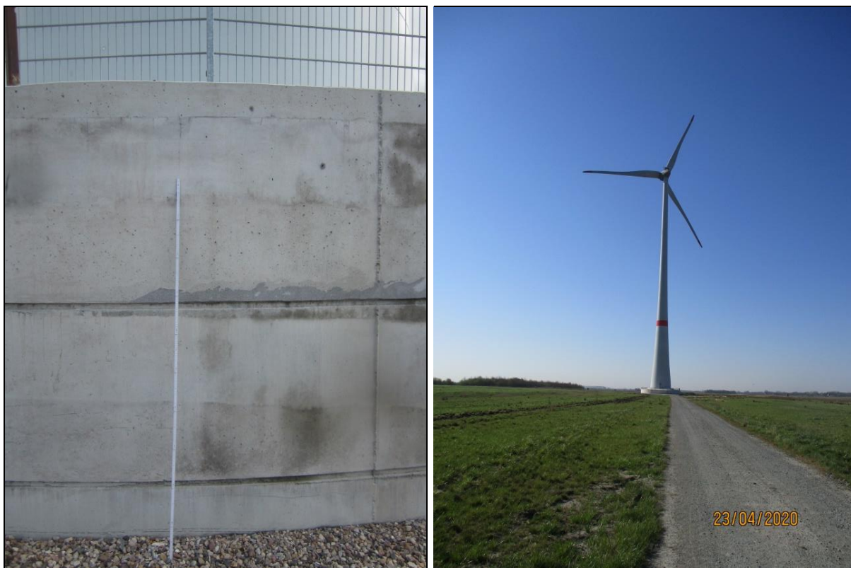
Abbildung 14: Das linke Foto zeigt beispielhaft eine Enercon 115 mit oberirdischem Fundament Höhe 2,50 m. Das rechte Foto zeigt die Enercon 115 aus größerer Entfernung (Quelle: Abbildung 29 des LBP 21.021, INGENIEURBÜRO PROF. DR. OLDENBURG GMBH, 2021E).
