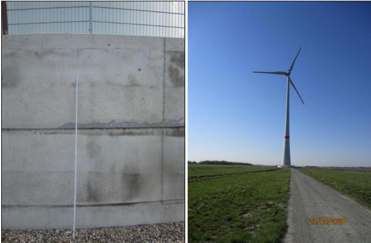
**Abbildung 29:** Das linke Foto zeigt beispielhaft eine Enercon 115 mit oberirdischem Fundament Höhe 2,50 m. Das rechte Foto zeigt die Enercon 115 aus größerer Entfernung.
