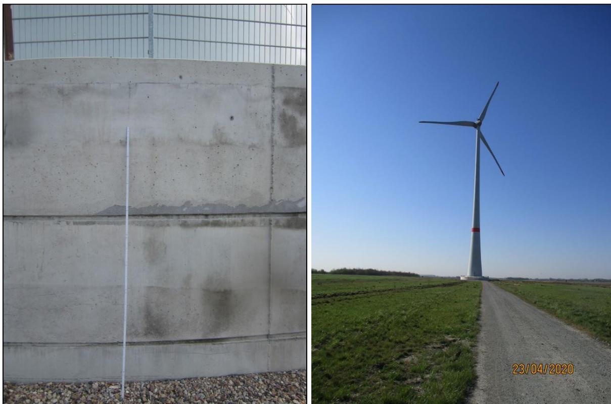
**Abbildung 14:** Das linke Foto zeigt beispielhaft eine Enercon 115 mit oberirdischem Fundament Höhe 2,50 m. Das rechte Foto zeigt die Enercon 115 aus größerer Entfernung (Quelle: Abbildung 42 des LBP 21.155, INGENIEURBÜRO PROF. DR. OLDENBURG GMBH, 2021E).
