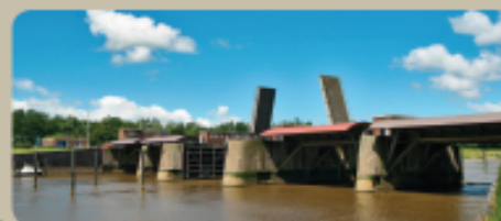
Zum Hochwasserschutz gehört auch die Abdämmung der Nebentasse. Wie hier an der Orde sind die Mündungen mit Sperrwerken versehen, die bei Sturmflut geschlossen werden.
